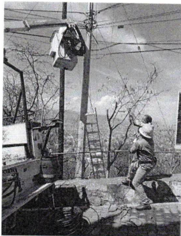
Trabajos en el Cerro del Fortín, para proporcionar nueva alimentación eléctrica a los circuitos de alumbrado público.
