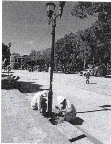
Mantenimiento a las conexiones eléctricas en los registros de las luminarias instaladas en la Alameda de León.
