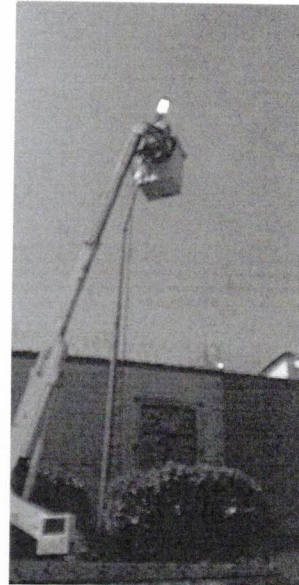
Rehabilitación de luminaria con altura especial ,afectada por robo de cable subterráneo en la calle de Margarita Maza casi esquina con Pino Suárez
