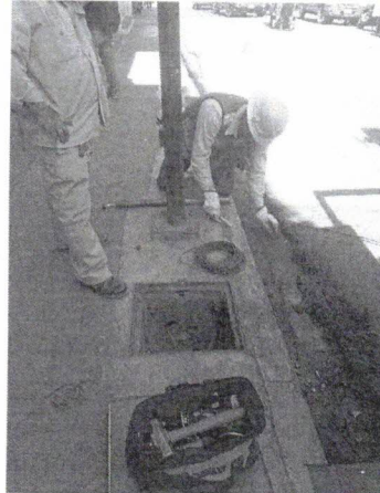
Interviniendo circuito de luminarias en la calle de Zaragoza esquina Mier y Terán afectado por robo de cable
