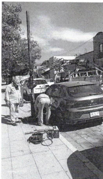
En la calle de Reforma interviniendo y sustituyendo poste en mal estado afectado por la corrosión y el paso del tiempo, postes con más de 30 años, instalados
