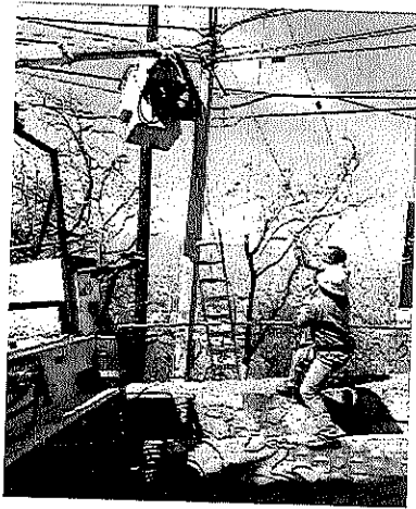
Trabajos en el Cerro del Fortín, para proporcionar nueva alimentación eléctrica a los circuitos de alumbrado público.
