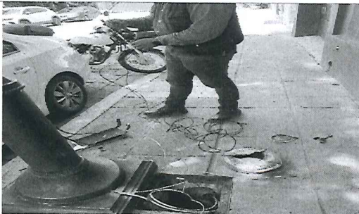
Reposición de cableado eléctrico en el circuito de Carr. Internacional 190, Pueblo Nuevo
